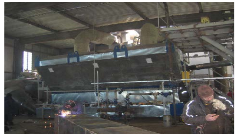
Сушилка производительностью 2,5 т/час испаряемой влаги на стадии монтажа
